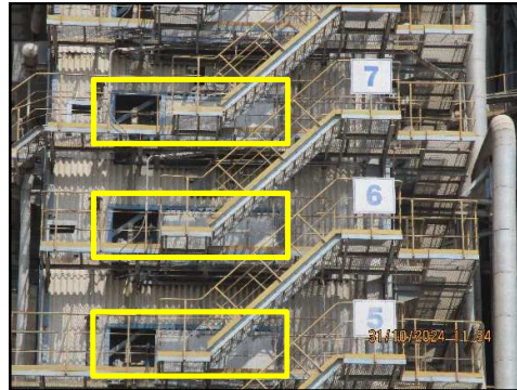
ภาพที่ 3.53 Casing ทุ้มชุด Hammering Equipment ในหม้อไอน้ำ
